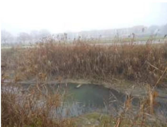
Scarico del sistema di via Marinella.
