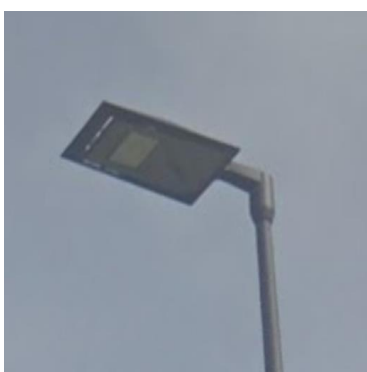
Figura 27 – Apparecchio di arredo a testa palo
