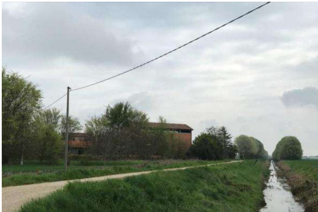
Figura 2-24: Ruedi di edifici rurali in prossimità di Via Valle Ossi e del Canale Ossi nella porzione meridionale dell'area d'intervento
