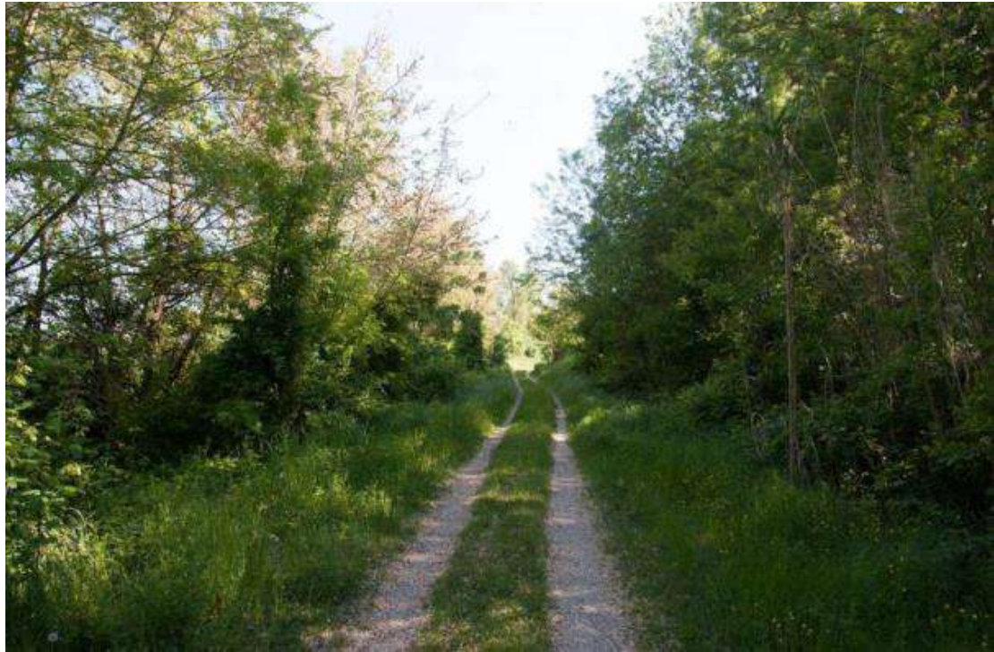
Figura 2-39: Percorso esistente lungo l'argine del Fiume Piave e del Canale Revedoli, al perimetro occidentale dell'area d'intervento
