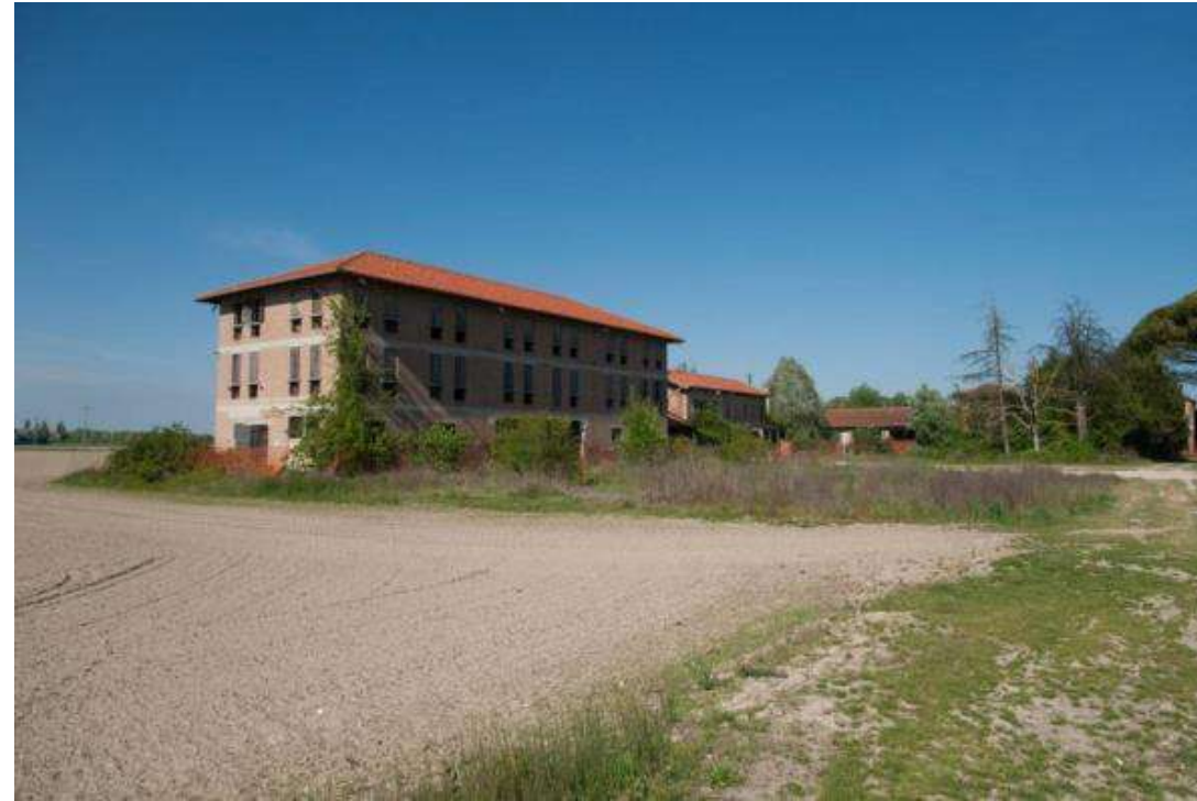
Figura 2-25: Ruedi di edifici rurali in prossimità di Via Valle Ossi e del Canale Ossi nella porzione meridionale dell'area d'intervento
