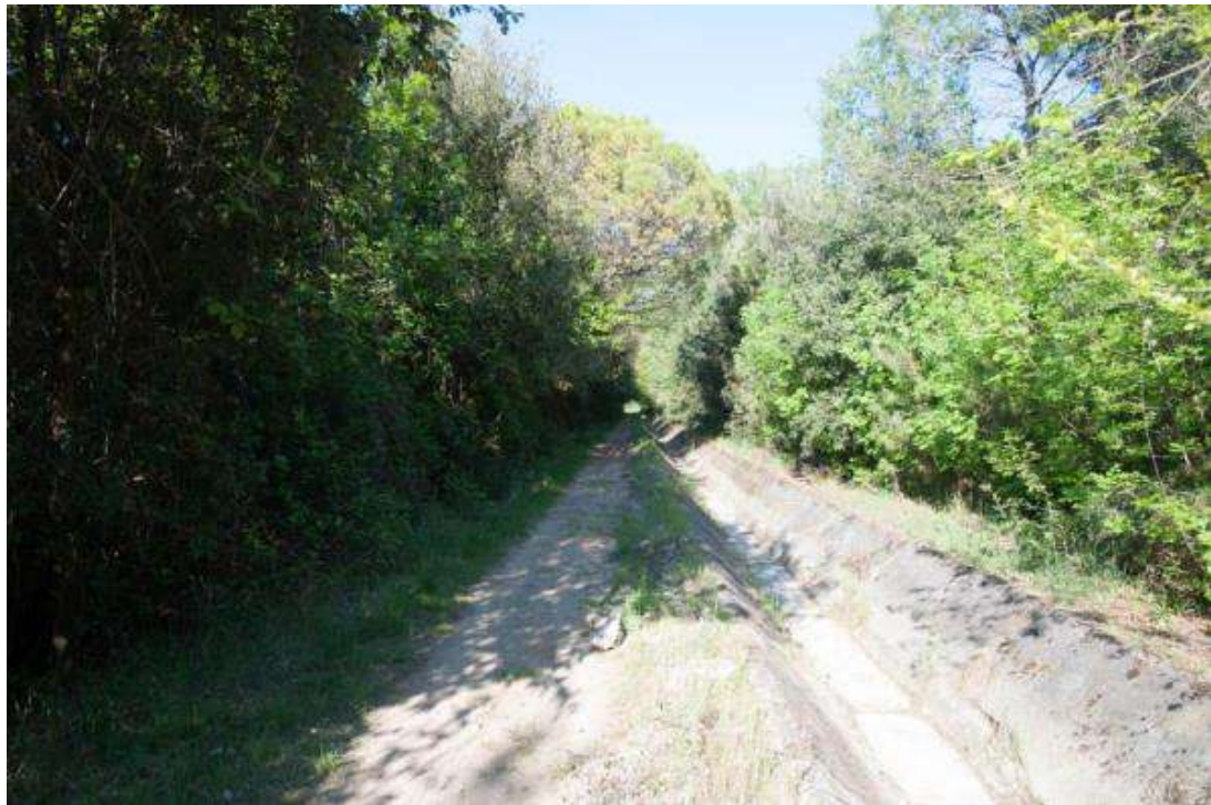
Figura 2-28: Canaletta principale della rete irrigua consorziale che, provenendo da est, corre lungo il margine nord della pineta, in periodo asciutto
