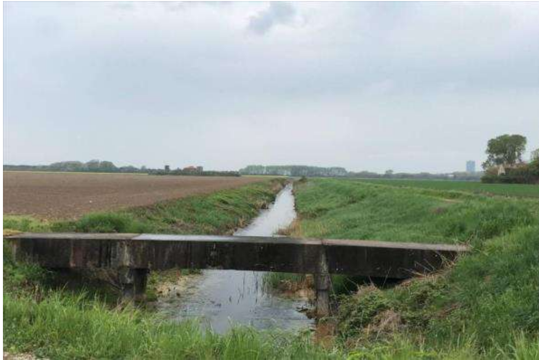
Figura 2-23: Canale Ossi nella porzione meridionale dell'area d'intervento
