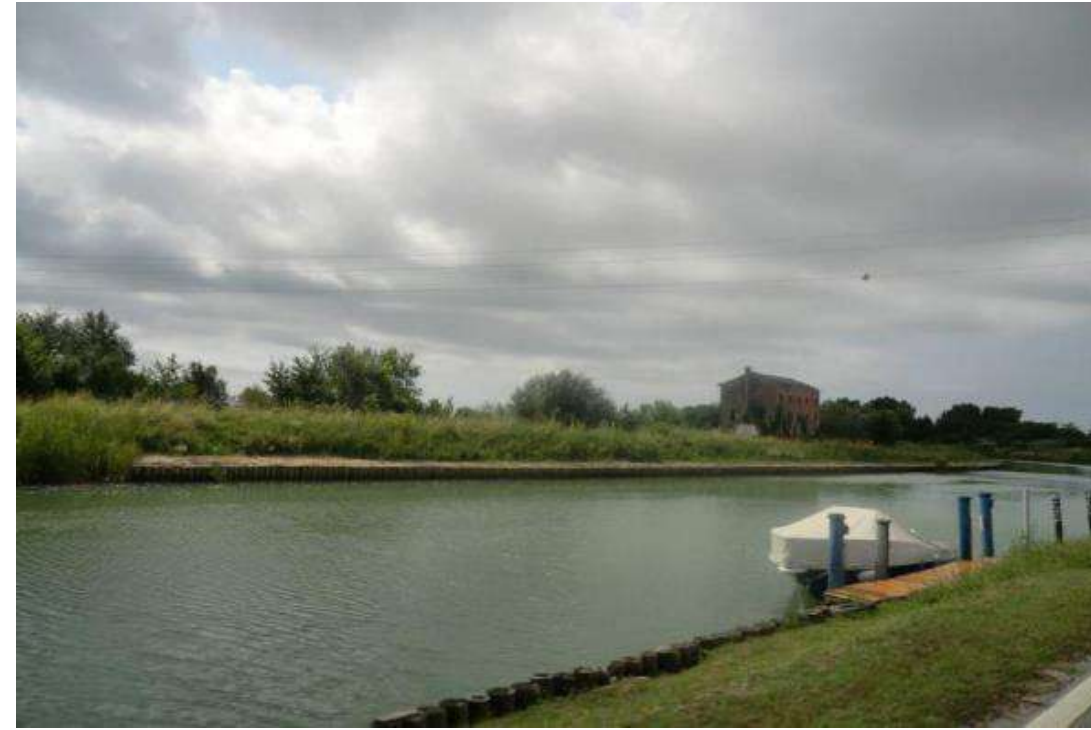
Figura 2-17: Linea MT che attraversa il Canale Revedoli a nord ovest dell'area d'intervento
