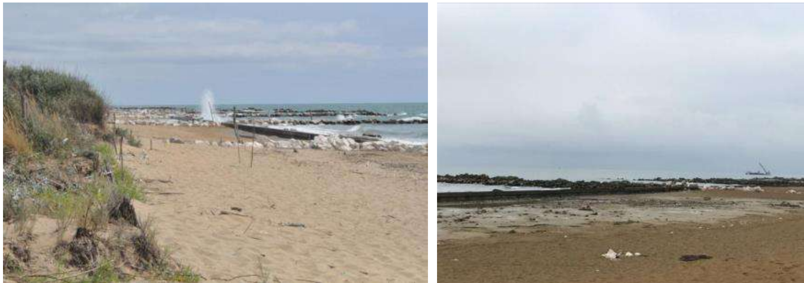
Figura 2-5: Spiaggia della Laguna del Mort, a sud ovest dell'area d'intervento; si nota il diaframma in calcestruzzo, emergente rispetto alla spiaggia, e i pennelli in pietra
