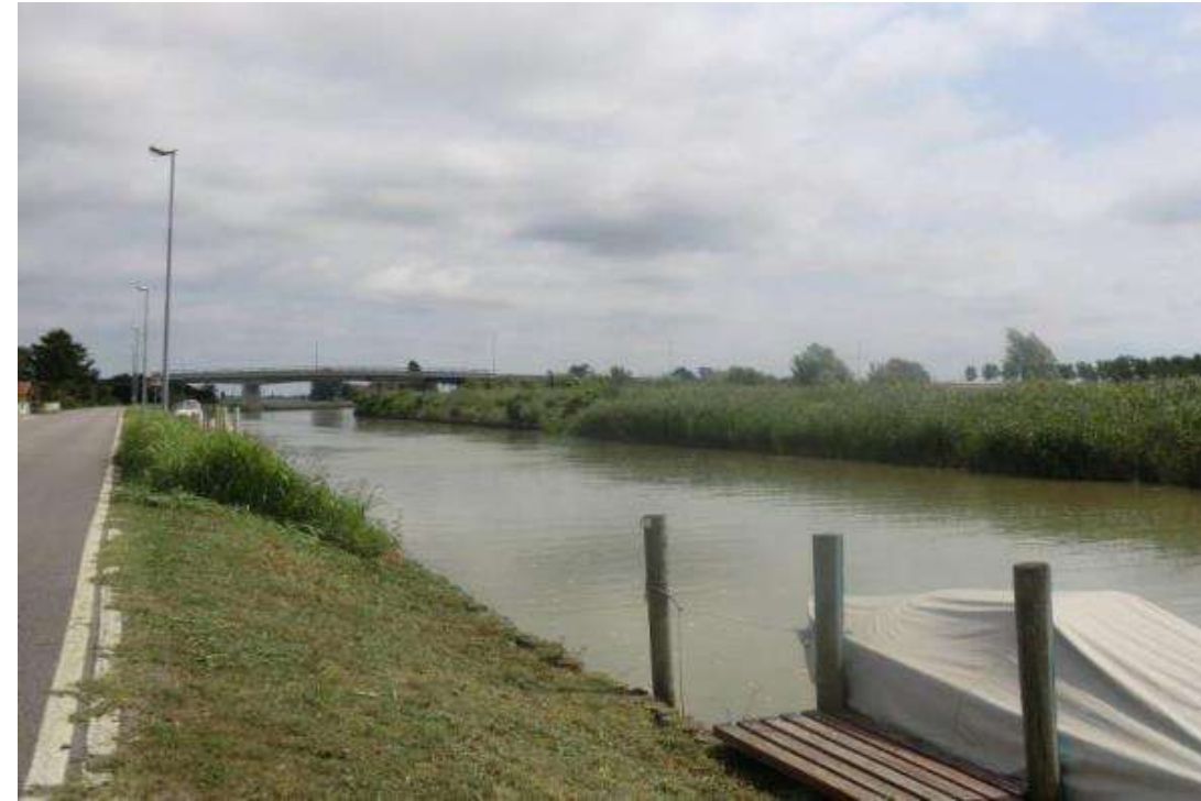
Figura 2-18: Ponte lungo la SP 90 sul canale Revedoli; a destra l'ambito PUA
